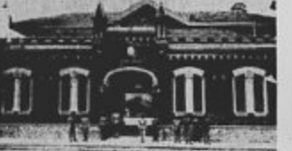
Edifício do quartel de Corpo de Bombeiros de Nitercy
